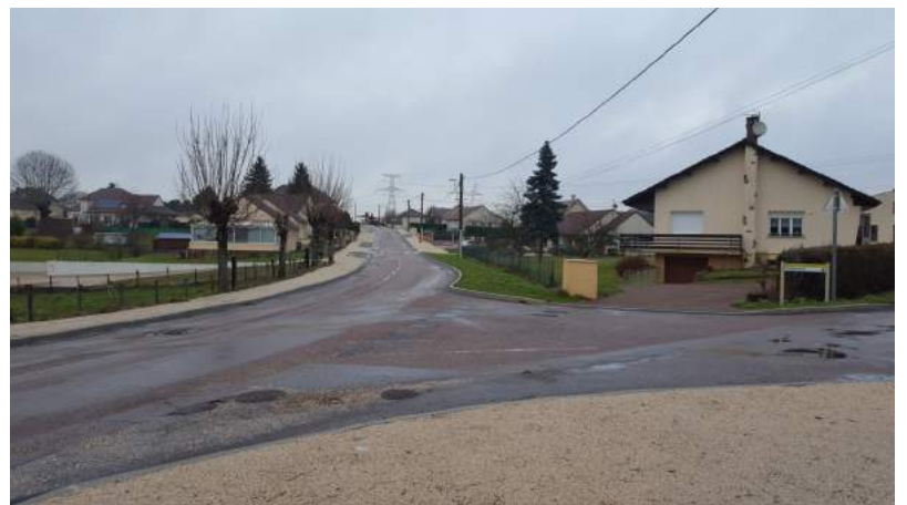
L'avenue de la Brenne, création de trottoirs
